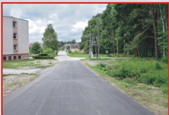
Przebudowa ul. Nowej w Murzynie - 609.586,55 zł
