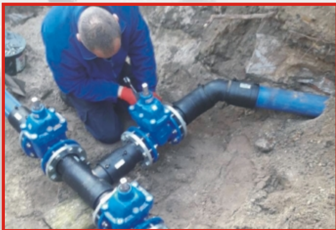
Wodociąg z Krobielewka do Wiejce - 414.176,97 zł,
