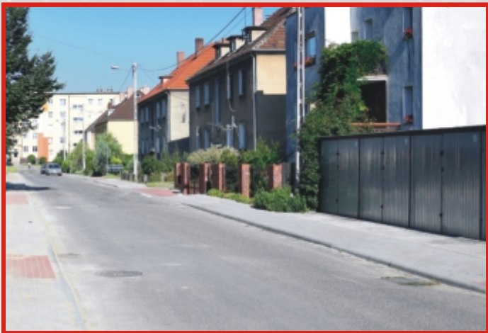
Remont chodnika na ul. Kopernika - 92.010,00 zł
