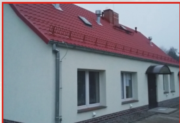
Remont świetlicy wiejskiej w Krobielewku - 271.394,96 zł
