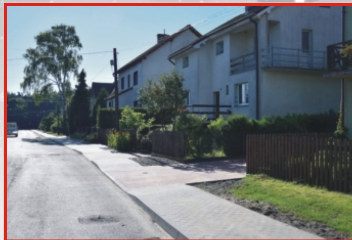
Remont chodnika na ul. Kopernika - 125.718,05 zł
