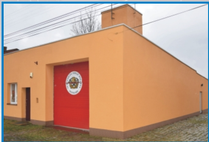
Remont elewacji remizy Ochotniczej Straży Pożarnej w Świniarach - 22.000,00 zł
