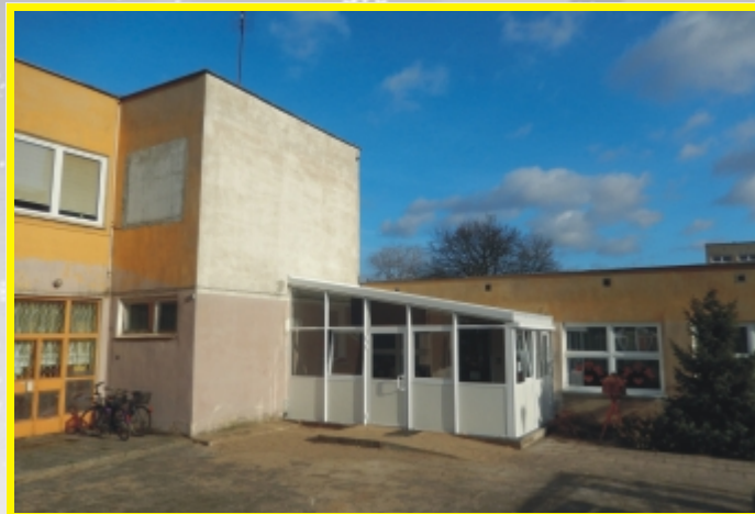
Budowa wiaty przy Przedszkolu Integracyjnym w Skwierzynie - 46.500,00 zł
