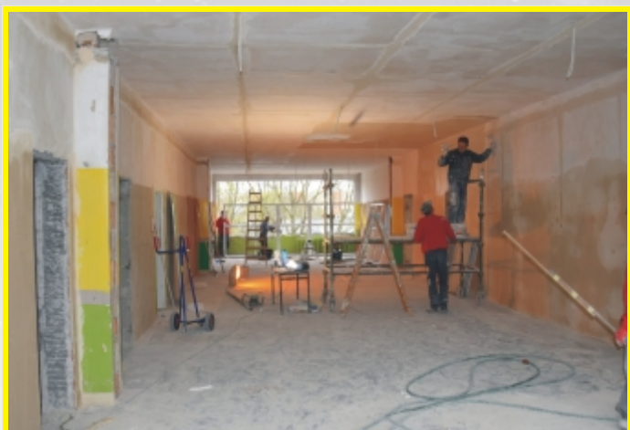
Przebudowa segmentu D na potrzeby przedszkola - 1.549.290,82 zł zakończenie inwestycji: marzec 2018
