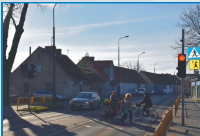
Montaż sygnalizacji świetlnej przy Gimnazjum - 35.000,00 zł
