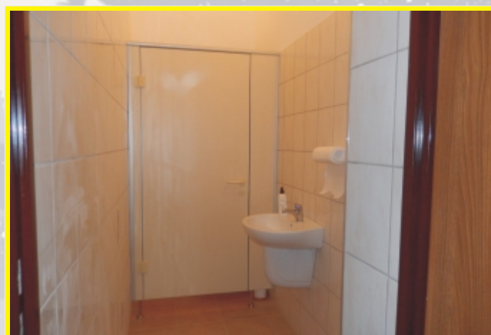
Remont sanitariatów w Zespole Edukacyjnym - 98.146,79 zł
