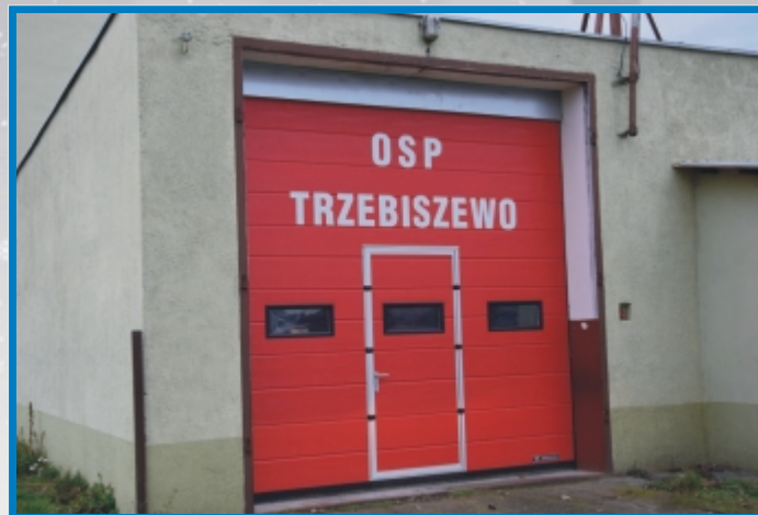
Wymiana bram garażowych w remizach oraz instalacja systemu selektywnego alarmowania dla OSP Murzynowo i Trzebiszewo - 31.000,00 zł,
