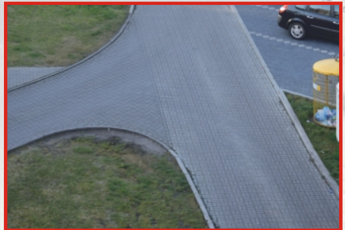
Remont drogi na Os. Grunwald - 74.458,05 zł
