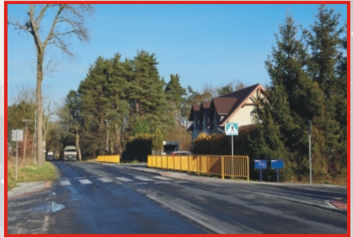
Budowa chodnika na ul. Bledzewskiej - 150.000,00 zł,
