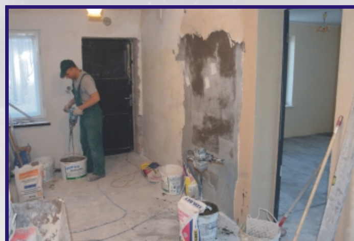
Remont pomieszczeń szatni ZLKS Budowlani Murzynowo - 89.542,83 zł
