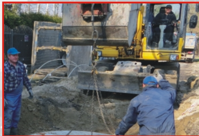
Infrastruktura Wodno - Kanalizacyjna na terenie Gminy Skwierzyna - 1.923.705,55 zł (2015 - 2017)
