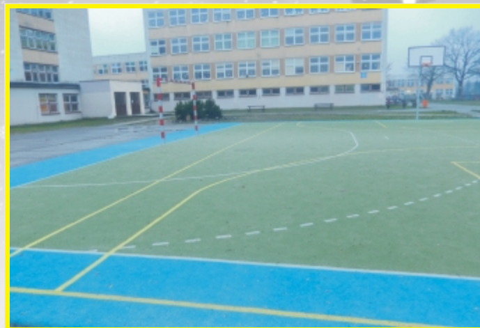
Budowa boiska wielofunkcyjnego przy Zespole Edukacyjnym - 373.797,00 zł
