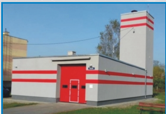
Remont elewacji wraz z dociepleniem budynku remizy OSP Murzynowo - 40.500,00 zł
