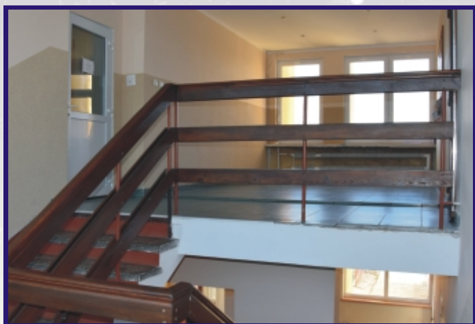
Remont budynku OSiR - 65.000,00 zł
