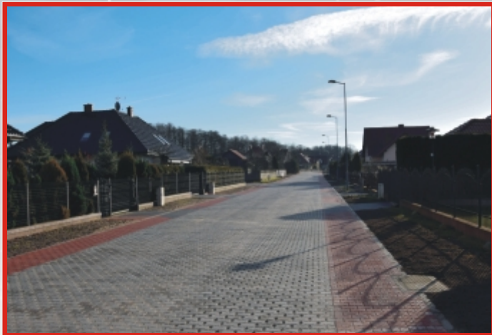
Budowa dróg na Os. Olszynki - 2.047.234,53 zł
