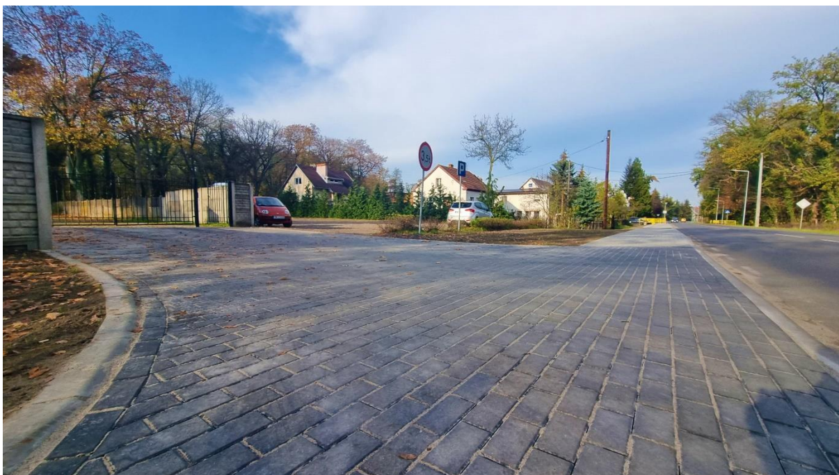
Budowa chodnika pomiędzy cmentarzami komunalnymi, kwota inwestycji: 471 640,43 zł
