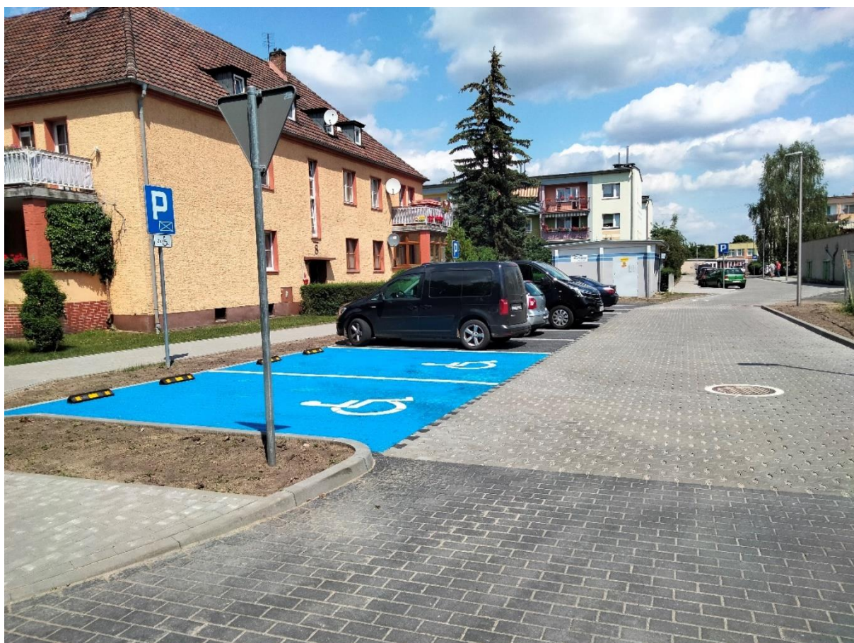
Przebudowa ul. Gimnazjalnej, kwota inwestycji: 670 586,16 zł
