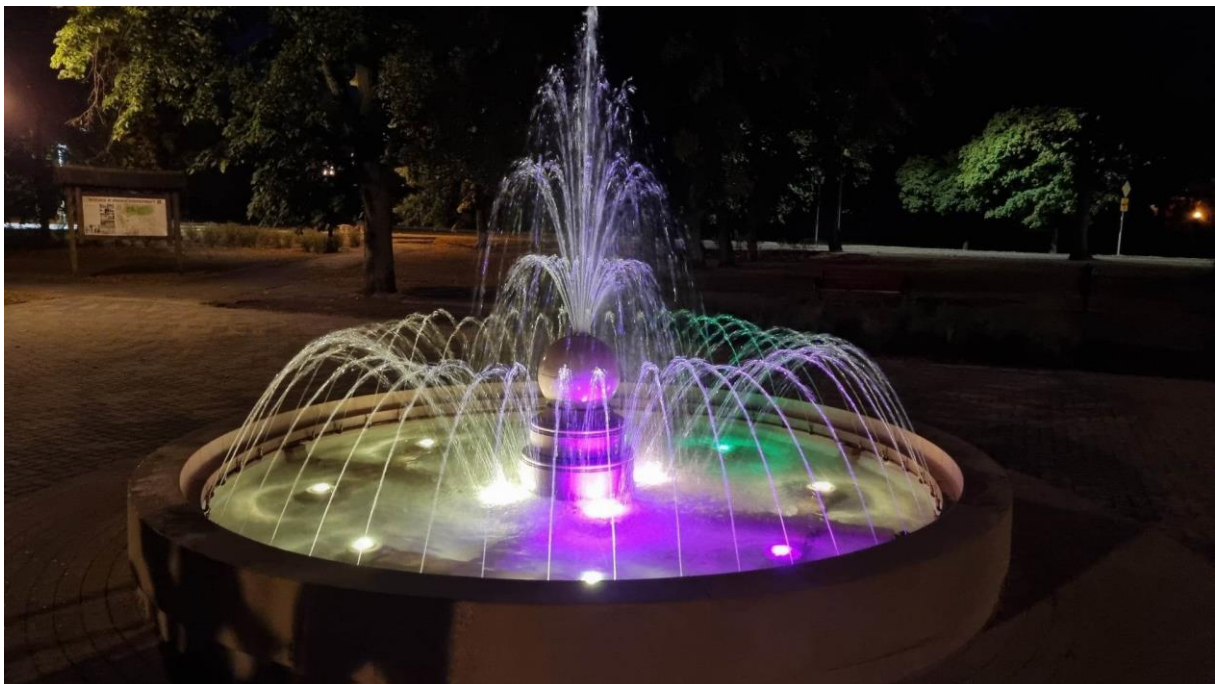
Budowa fontanny wraz z otoczeniem w Parku Konstytucji 3. Maja, kwota inwestycji: 295 619,10 zł
