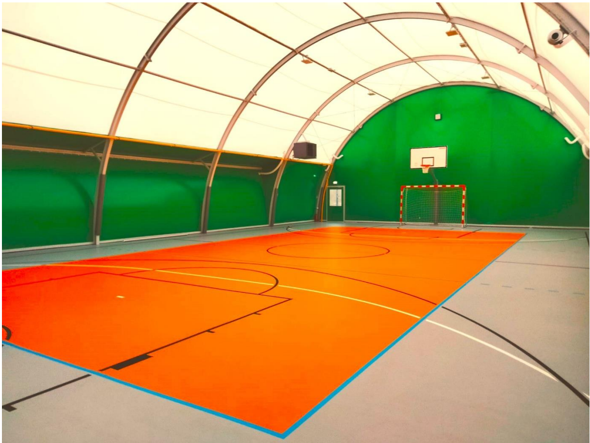
Budowa hali sportowej w Trzebiszewie, kwota inwestycji: 1 198 873,48 zł
