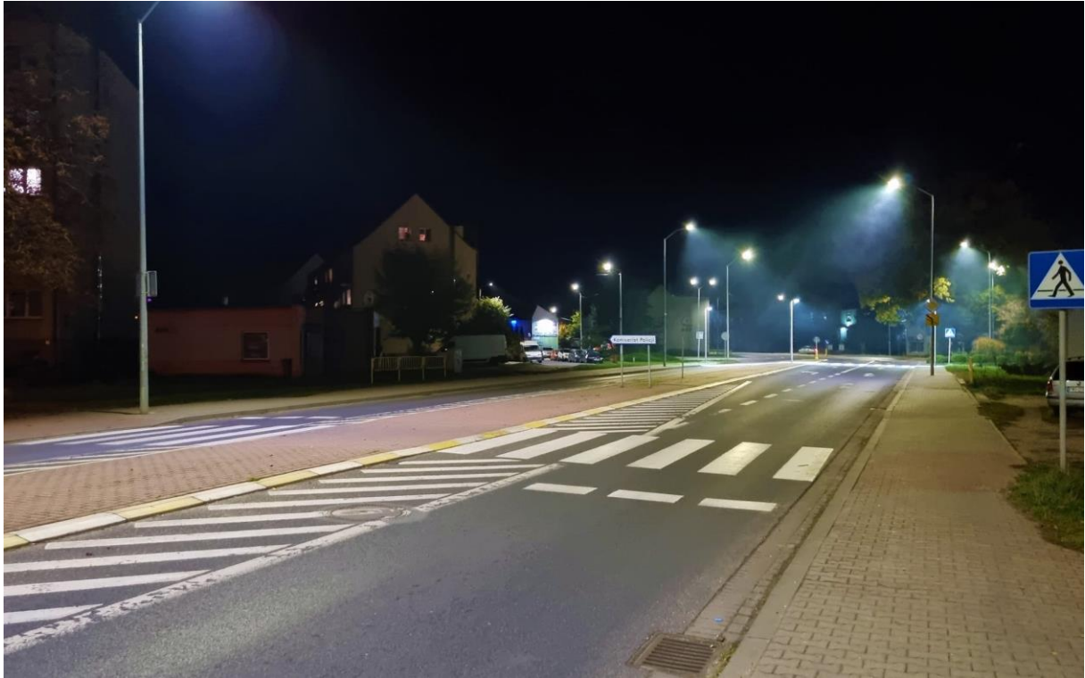
Modernizacja oświetlenia ulicznego na terenie Gminy Skwierzyna, kwota inwestycji: 2 435 062,47
