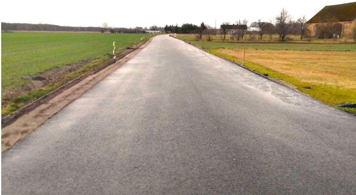
Przebudowa drogi w miejscowości Gościnowo, kwota inwestycji: 760 360,63 zł
