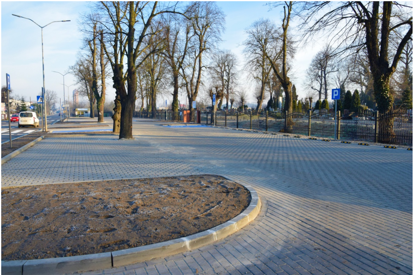
Budowa drogi w Gościnnie - etap I
